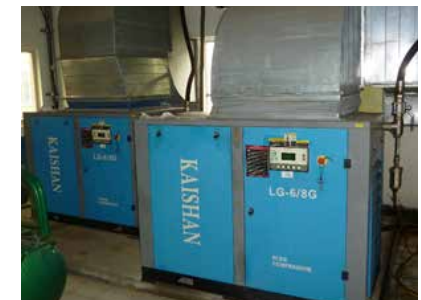
2017年設置之 50HP 低馬力空壓機
